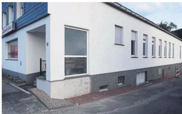
Nach dem Wasserschaden im Keller der Hüinghauser Rammberghalle musste an der Außenfassade eine neue Drainage mit Schotter her.
